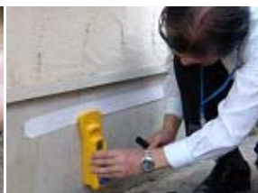
鉄筋探査器（黄色の機械）で基礎に鉄筋が施工されているか確認
