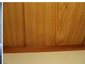
天井に漏水跡がないか確認
