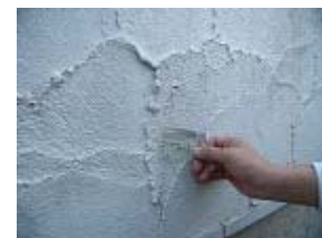
外壁のひび割れの確認
