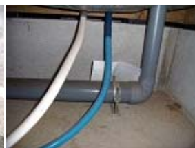
床下配管の状況確認
