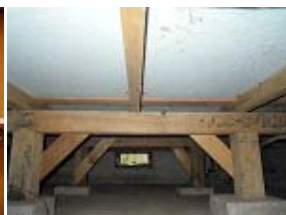
床下の施工状況を確認
