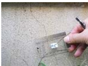
基礎のひび割れ幅が過大でないか
